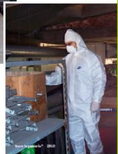
Muestreo ambiental de punto fijo para comprobar el correcto mantenimiento de los MCA (materiales con amianto), verificando que no se produce una liberación importante de fibras de amianto al ambiente.
